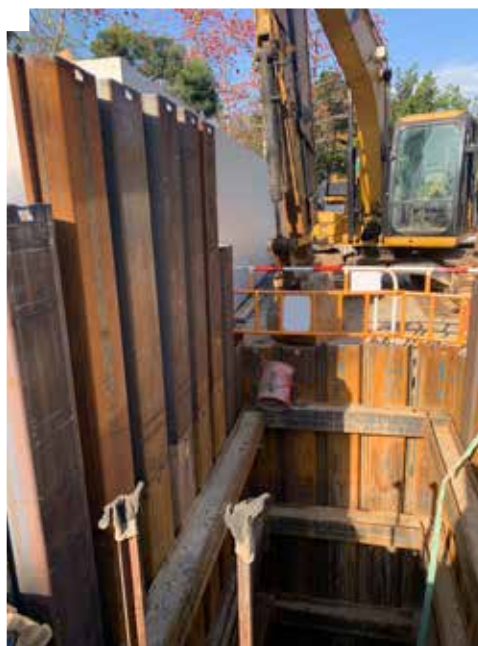
渠务署工程—挖掘工程
