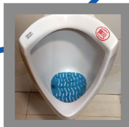
尿缸隔及排水道臭氣處理
